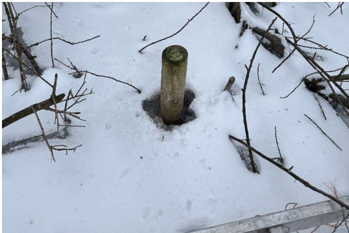
Pfahl bis auf ca. 30 cm zur Eisfläche einschlagen
